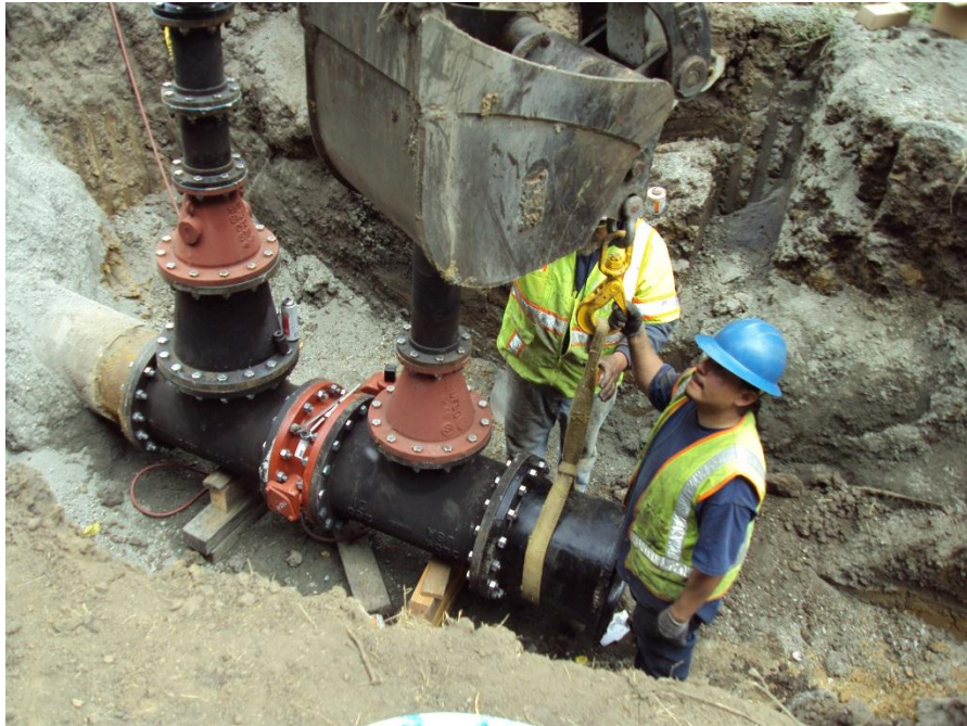
Mike Gibbs & Jose Velazco installing flange
